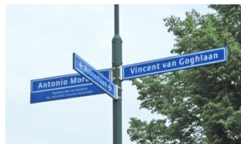
Flespaal met vlaggende dubbelzijdige straatnaamborden
