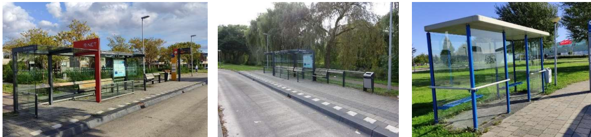
Verschillende basistypen abri's; links een R-Net abri op de halte Walt Disneyplantsoen, in het midden een niet-R-Net abri zoals op station Parkwijk en rechts een (smalle) OFN-abri op de halte Sallandsekant.
