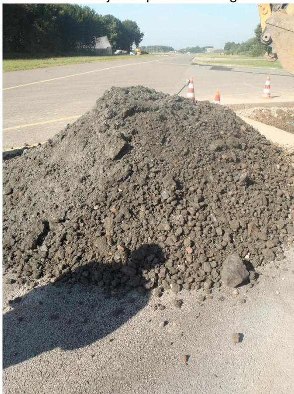
Locatie E4: Betonijzer in puinverharding
