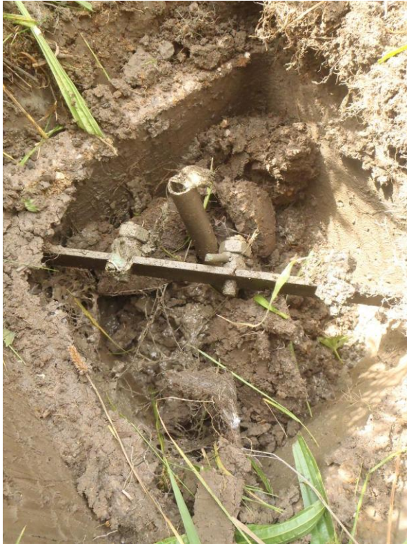
Locatie R7: gewapend beton en aardpen (niet verwijderd)
