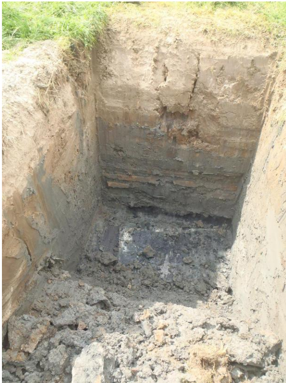
Locatie R1: betonfundering op 2m diep (niet verwijderd)
