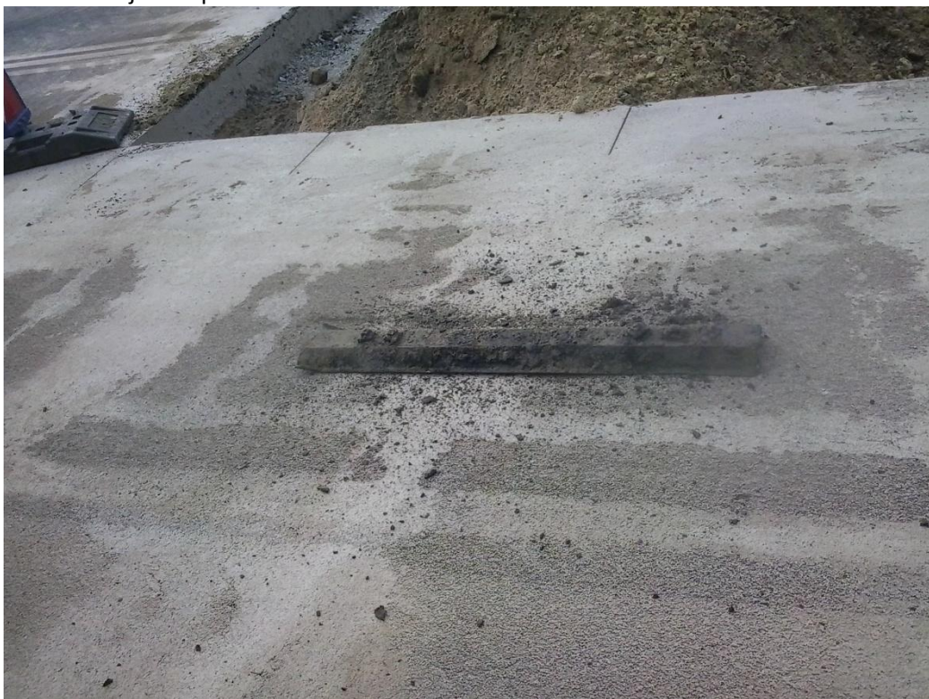
Locatie 11 smalspoor dwarsligger
