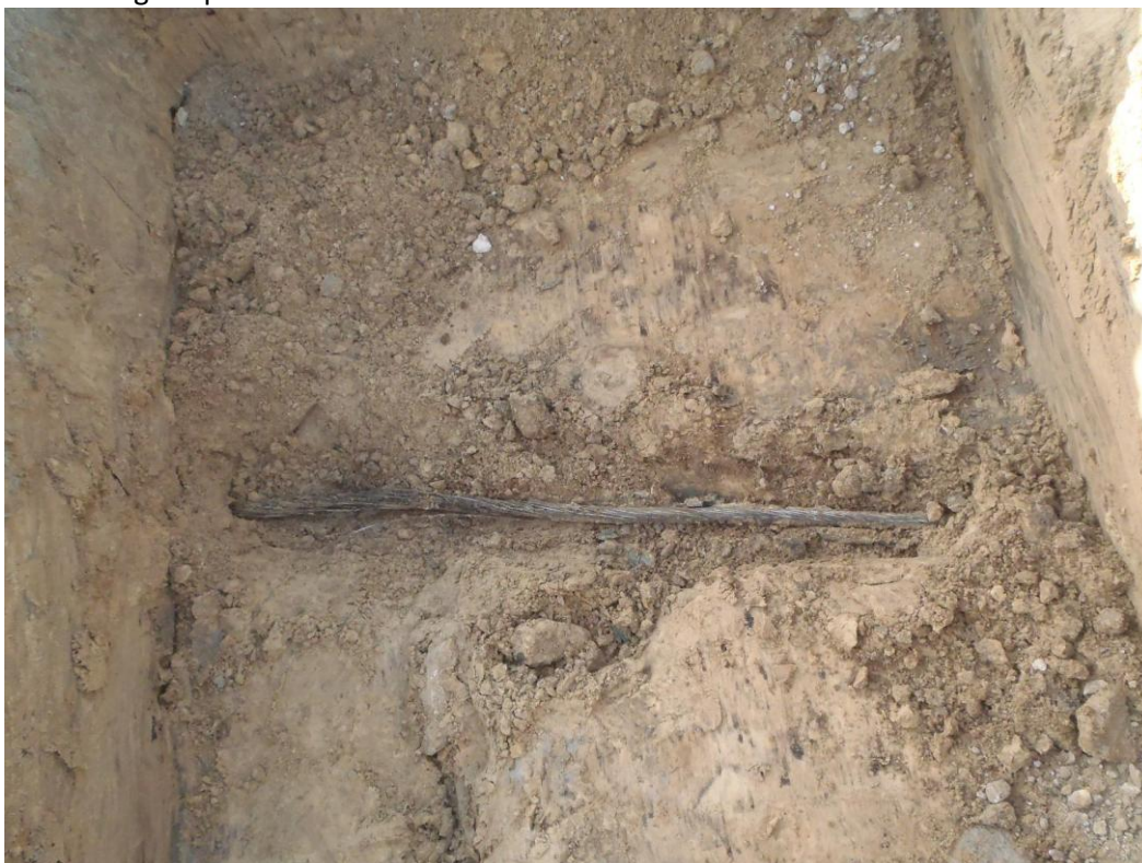
Locatie 8: oude kabel
