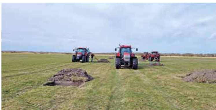
Voor het werk moeten de verzamelputten waarin de drainage uitmondt eerst worden opengemaakt.
