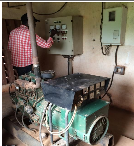
Groupe électrogène et l'armoire électrique
