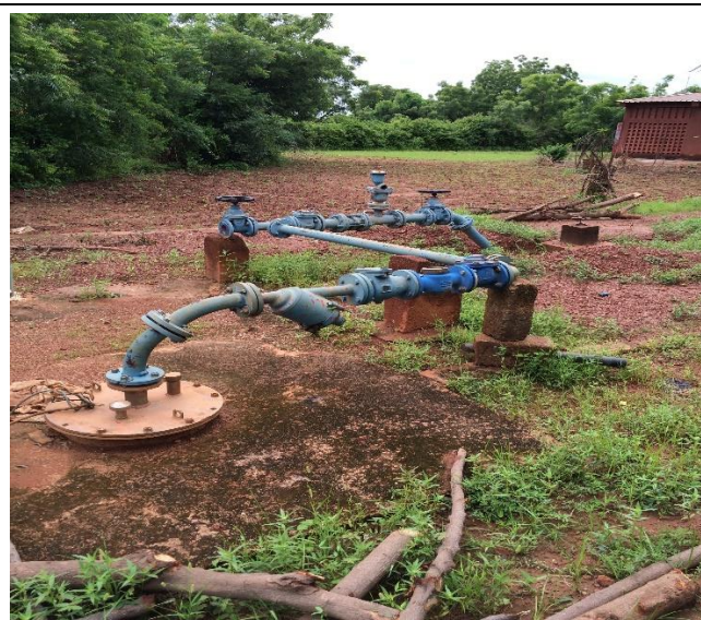
Tête de forage avec, une ventouse, un clapet anti retour, une vanne d'arrêt et un compteur.
