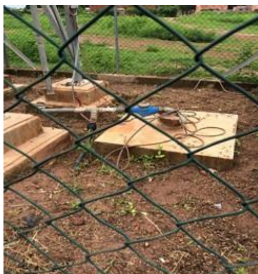
Un forage destiné à d'autre usage raccordé au réseau pour renforcer la production.
