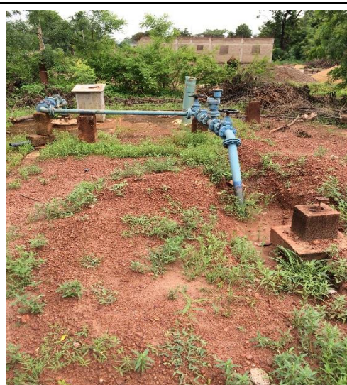
Tête de forage avec, une ventouse, un clapet anti retour, une vanne d'arrêt et un compteur.
