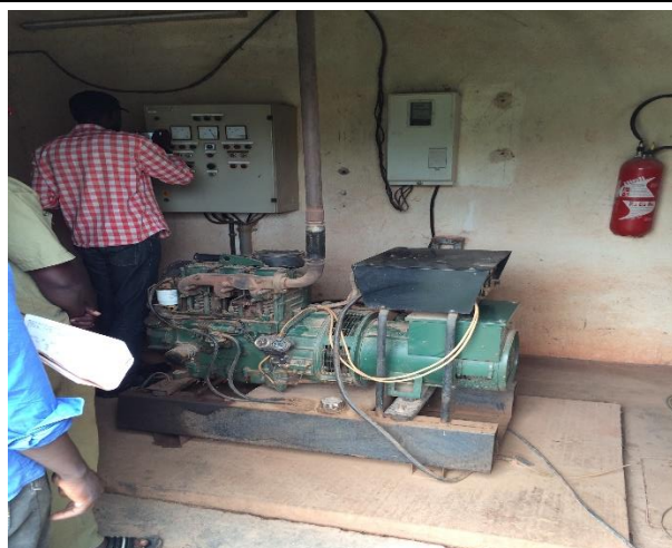
Groupe électrogène et l'armoire électrique
