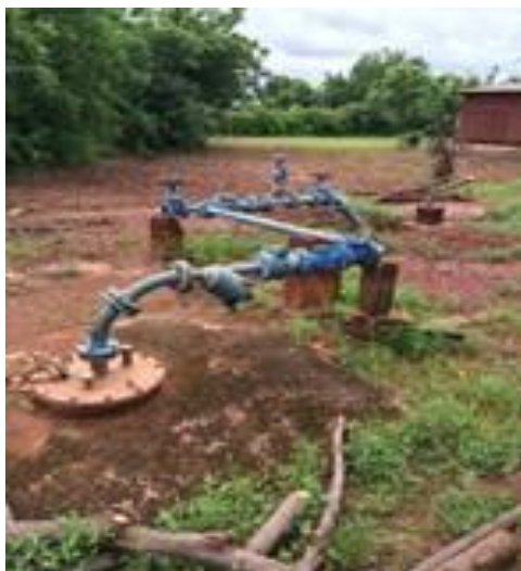
Tête du forage F1 dans la cour de la station de pompage et de traitement.
