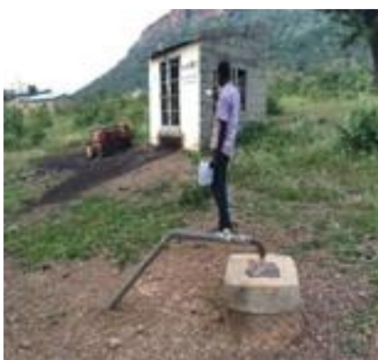
La tête du forage F4 (10 m 3 /h) et son local du groupe électrogène, ces coordonnées sont : 12°51'7.63"N et 11°13'31.52"O.
