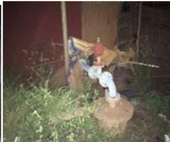
La tête du forage F6 (6 m 3 /h), ces coordonnées géographiques sont : 12°50'14.88"N et 11°14'4.57"O.
