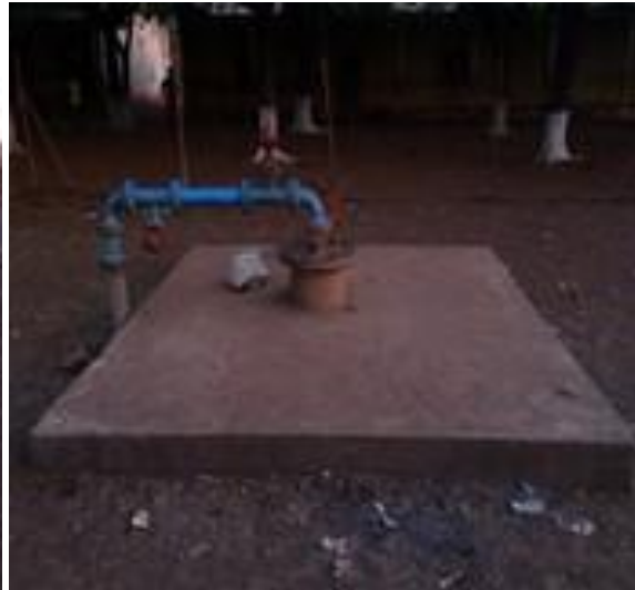
Le forage F5 (6 m 3 /h) dans la cour de l'école public est raccordé au réseau de distribution, ces coordonnées géographiques sont : 12°50'18.09"N et 11°13'53.53"O.
