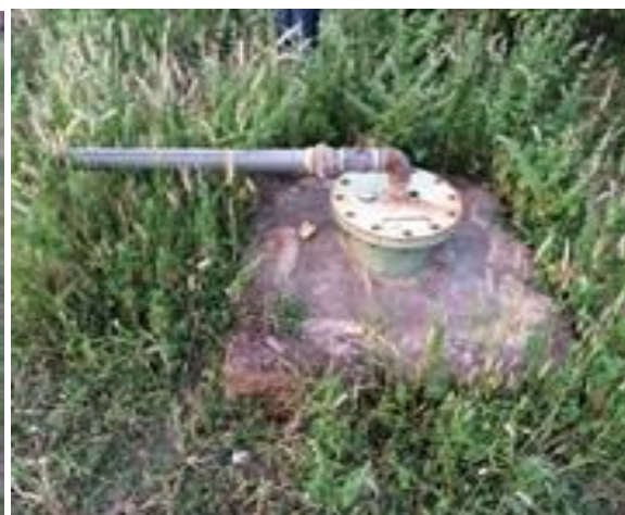
Tête du forage F3 (10 m 3 /h) et son local du groupe électrogène, ces coordonnées géographiques sont : 12°51'11.61"N et 11°13'33.54"O.
