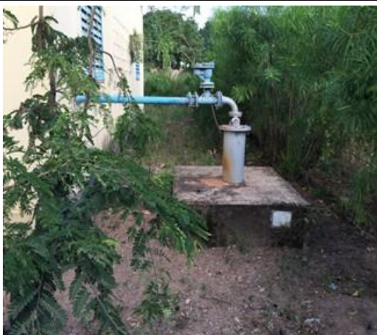
Tête de forage avec une ventouse
