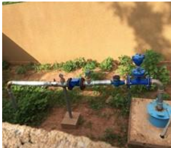
Tête de forage avec une vanne d'arrêt, un compteur et un clapet anti retour.
