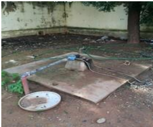
Une tête de forage F1 avec compteur
