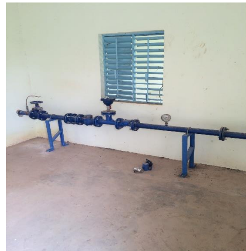
Tête de forage avec, une ventouse, un clapet anti retour, une vanne d'arrêt et un compteur.
