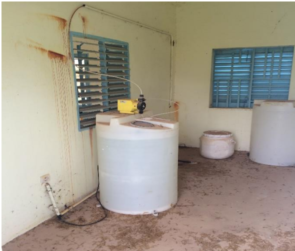
Bac à chlore et la pompe doseuse
