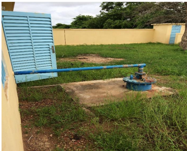
Tête de forage avec, une ventouse, un clapet anti retour, une vanne d'arrêt et un compteur.
