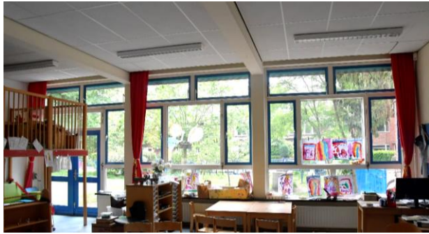
Foto lokaal met 2 betonnen spanten
