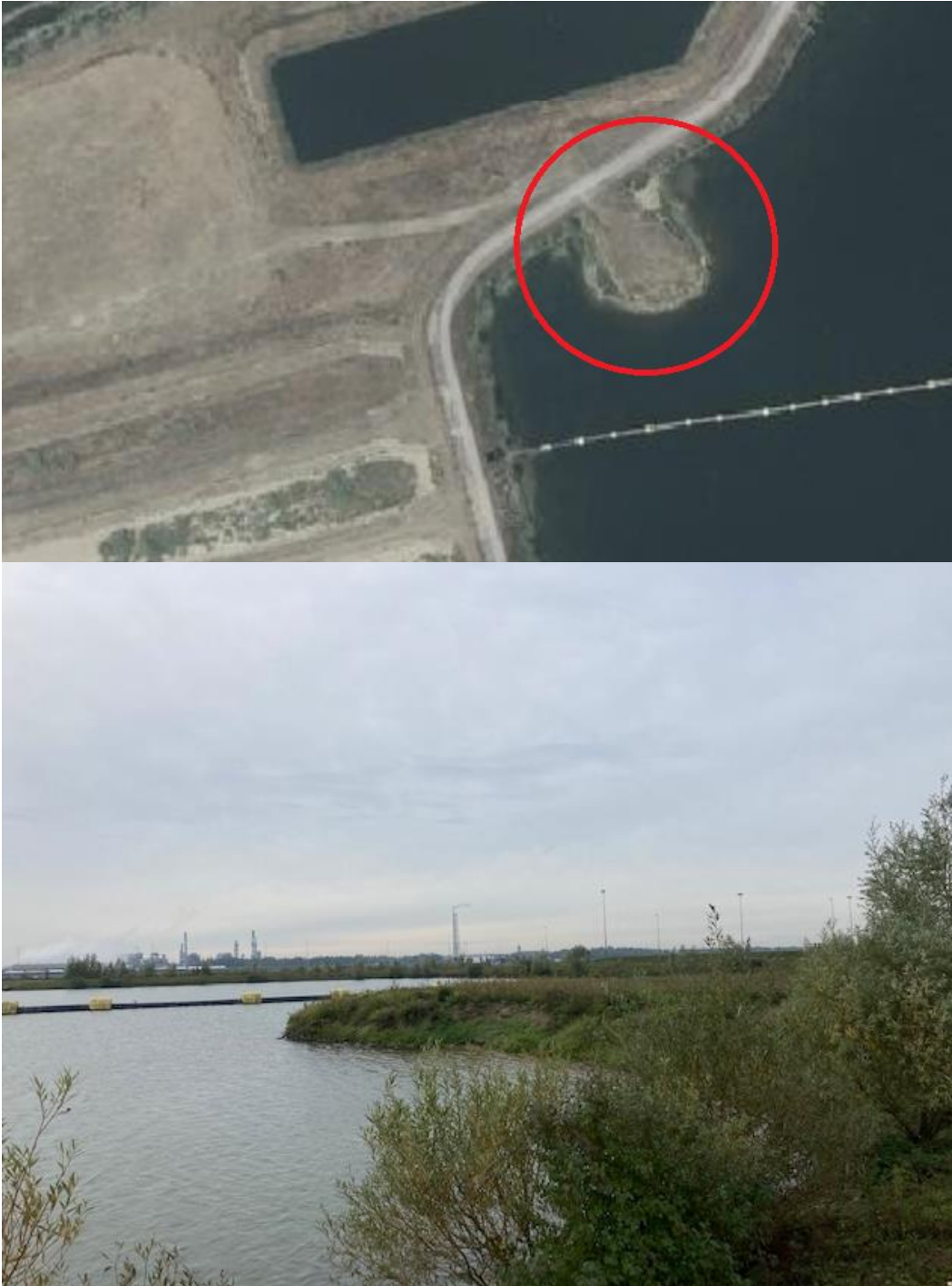
Figuur 10 storten van vast materiaal in baggerdepot
