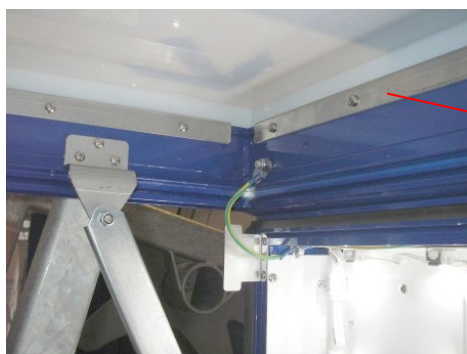
figuur 9 Detail klemprofielen
