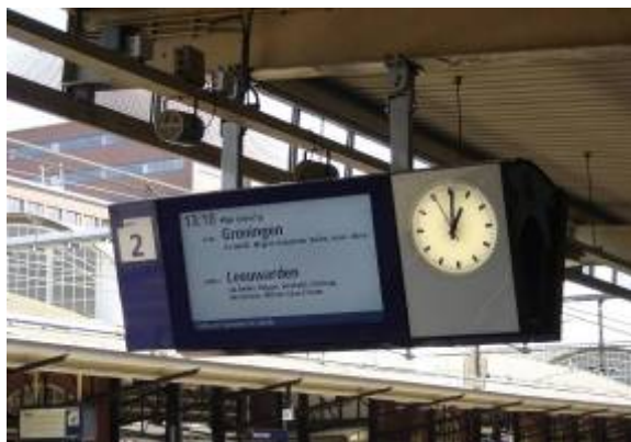
figuur 10 Bevestiging met pendels aan bestaande overkapping
