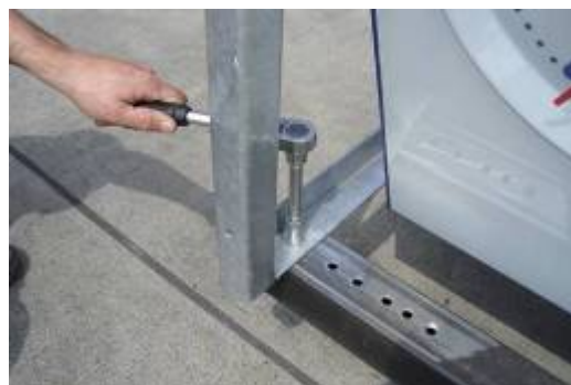
figuur 15 Demontage transportliggers
