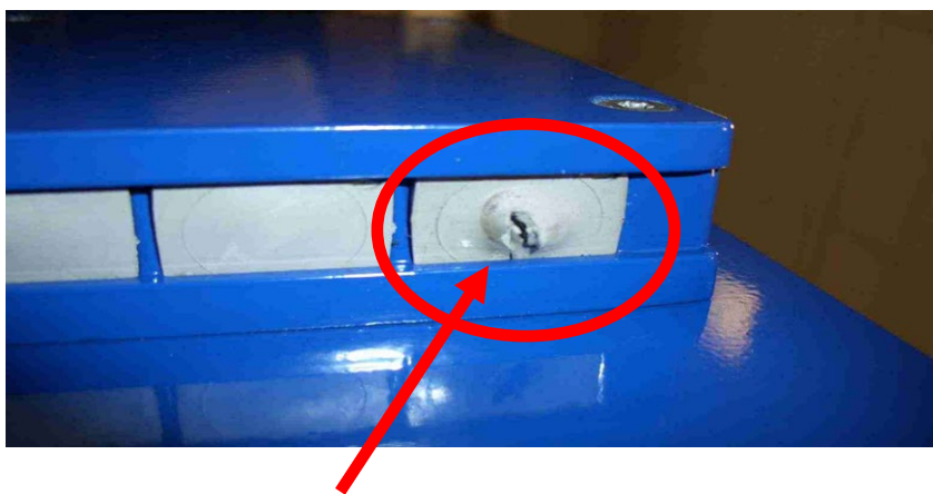
figuur 37 doorvoertule die handmatig is gewijzigd
