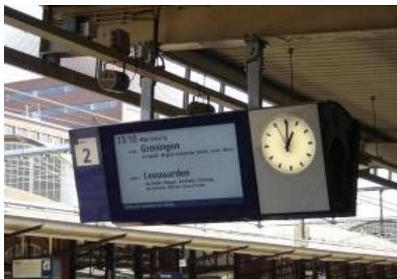
figuur 9 Bevestiging met pendels aan bestaande overkapping
