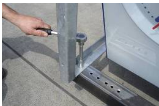
figuur 14 Demontage transportliggers
