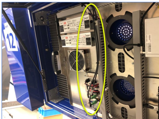
Figuur 6-19: Sensorkabels aansluiten op SensorBOX
