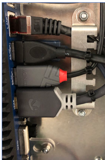
Figuur 6-24: Afwerking kabels Master-zijde
