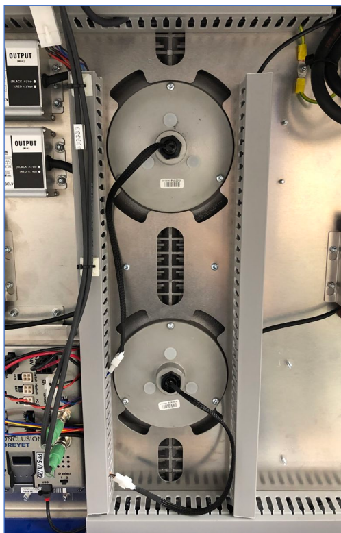
Figuur 7-4: Back fans plaatsen
