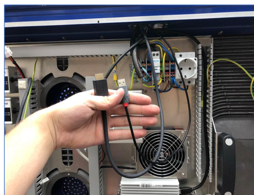
Figuur 6-9: Kabels door Cable Entrybox
