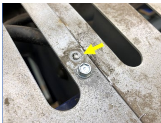
Figuur 7-6: Boorschroef naast gat schroeven
