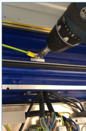
Figuur 6-21: Aardedraad vastzetten
