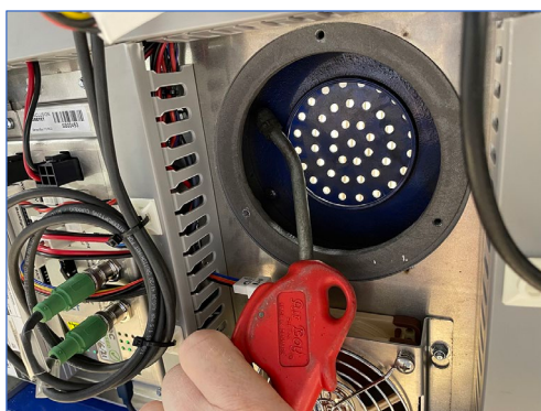
Figuur 7-3: Kanalen schoonblazen
