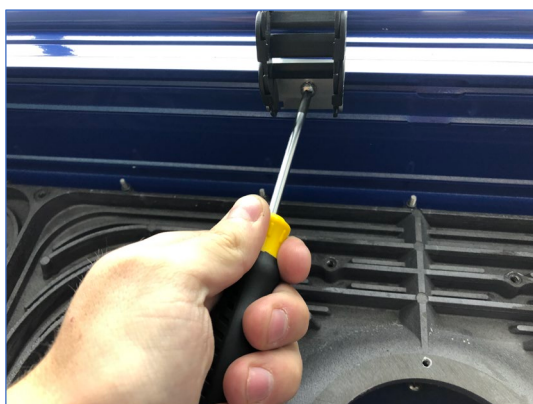
Figuur 5-11: Afgeknipte kabelrupskabels losschroeven
