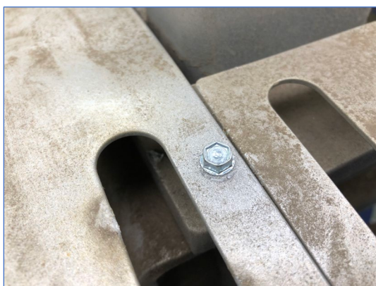
Figuur 7-5: Boorschroef in vrij gat schroeven
