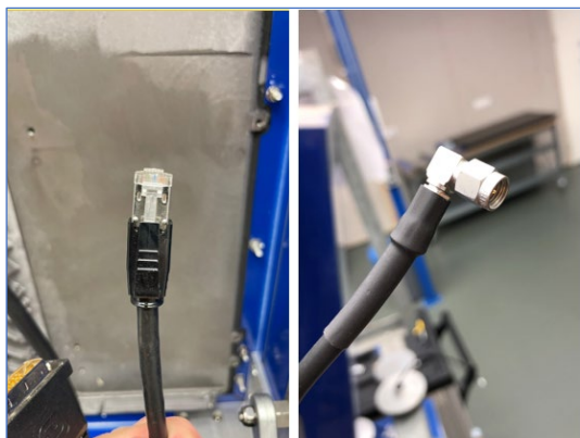
Figuur 5-6: Master-kabels loshalen
