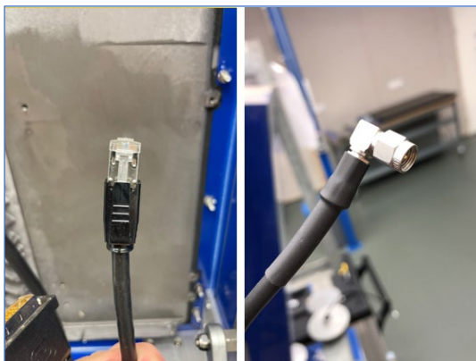
Figuur 5-13: Master-kabels loshalen
