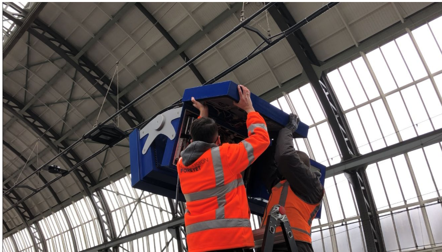
Figuur 5-6: Front uit scharnier tillen
