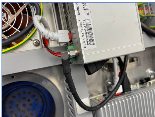
Figuur 6-9: Coaxkabel aansluiten op modem
