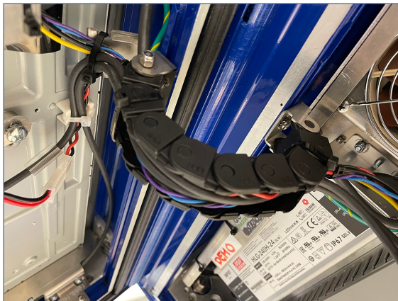
Figuur 6-29: Kabelbinders rups plaatsen
