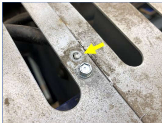
Figuur 7-6: Boorschroef naast gat schroeven
