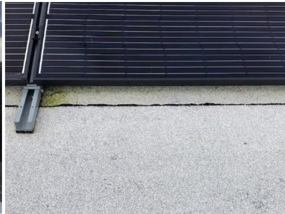
Weining afstand tussen bitumen en paneel
