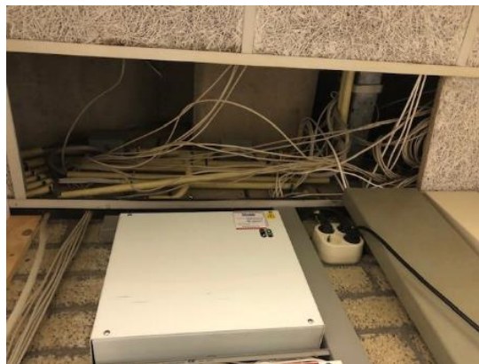
Ontbrekende plafondplaat
