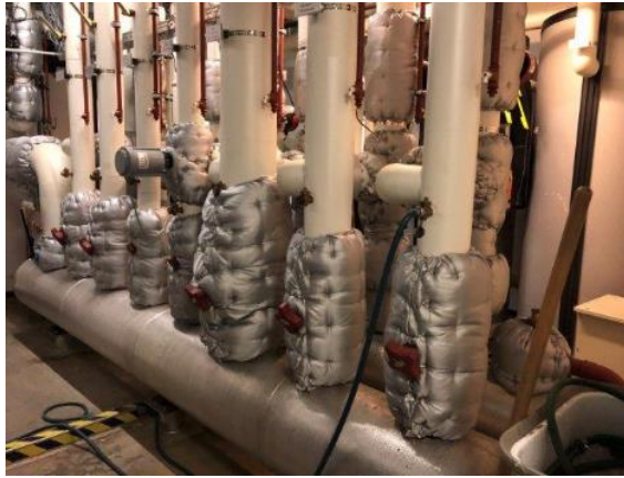
Kelder - pompkamer golfslagbad – doorvoeren niet afgedicht
