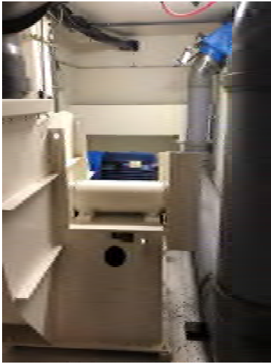
Kelder - pompkamer golfslagbad – doorvoeren niet afgedicht
