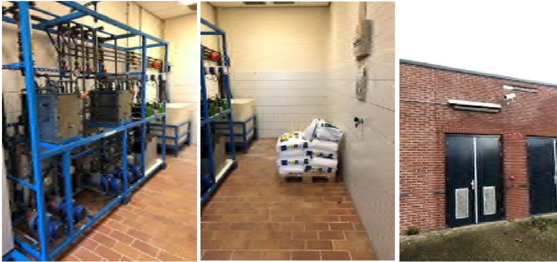
BG: technische en opslagruimtes aan de oostzijde van het gebouw
