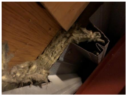
Isolatiemateriaal in schuine daken
