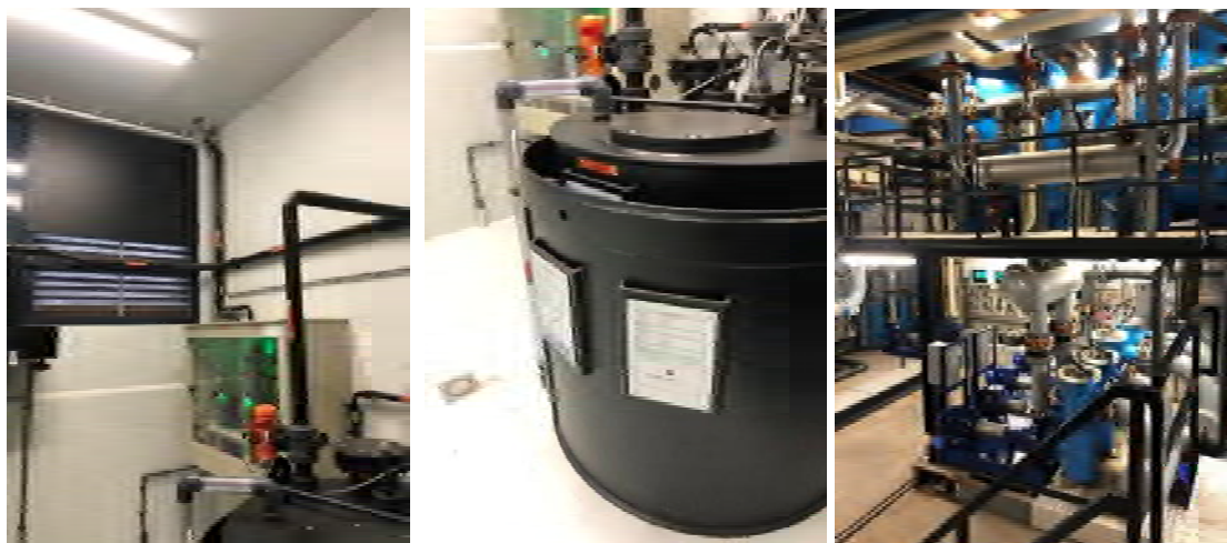
Kelder – aparte ruimte tbv zwavelzuur toevoeging
