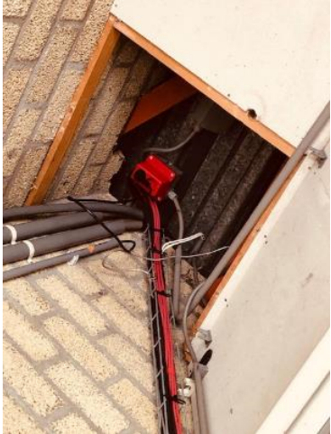
Plafondplaat ontbreekt in ruimte omvormers
