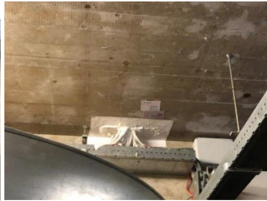
Doorvoeren correct afgewerkt
