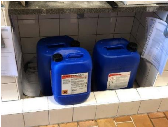
BG Opslag van chemicaliën binnen opgemetselde rand en op opvangbakken
