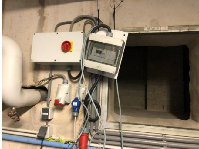
Inadequate elektrische aansluiting en opening in kelderwand
