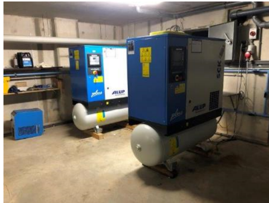
Inadequate elektrische aansluiting en opening in kelderwand
