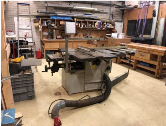
Houtwerkplaats en afzuiging
