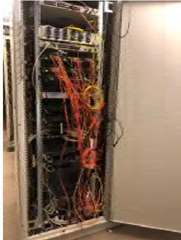
Doorvoeren correct afgewerkt
