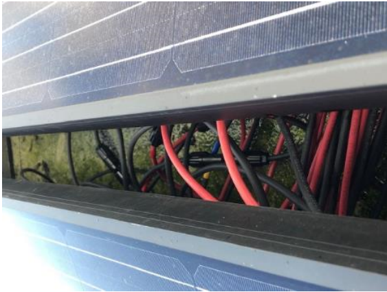
Bedrading zonnepanelen ligt los
