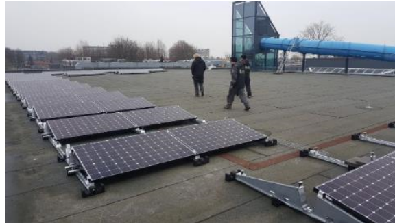
Open source foto aanleg zonnepanelen
