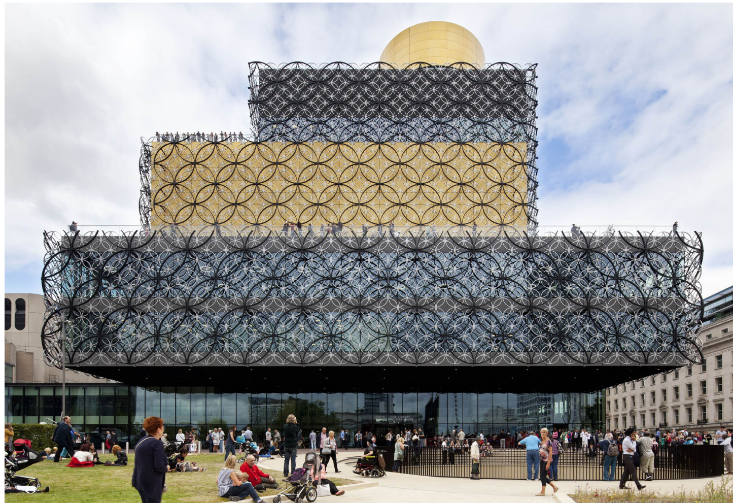
Eenheid door architectuur en materialisering, de verschillende functies herkenbaar
