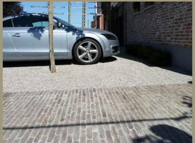
Grind met klinkerrand
