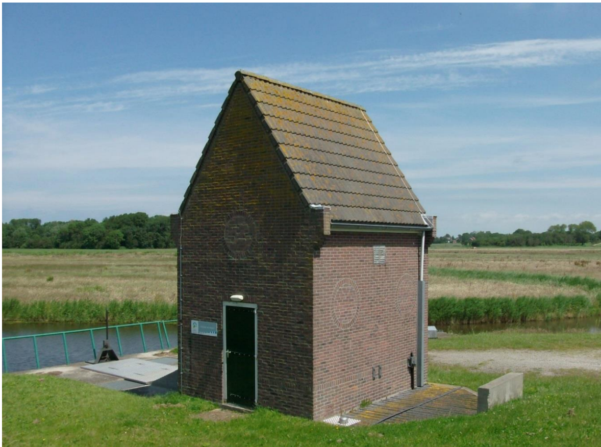
Gemaal De Hoelm met aan de rechterzijde de te lage uitstroombak tegen de kade
