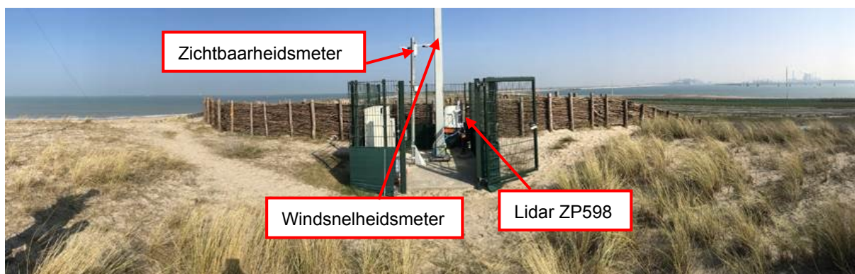
Figuur 1-3 Plaatsing van de Lidar naast de zichtbaarheidsmeter en windsnelheidsmeter van Havenbedrijf Rotterdam.
