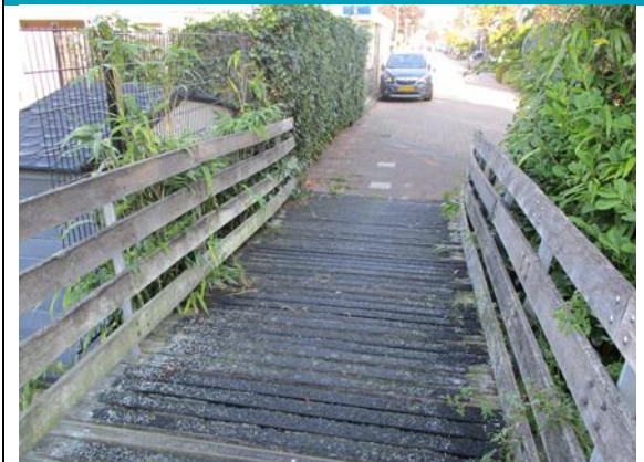
Foto - WAL-18 (brug wordt verplaatst)
