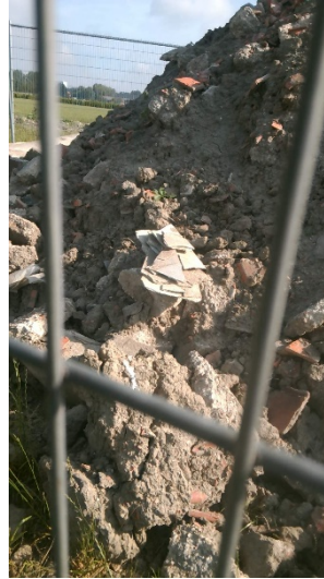
Foto 38: dam 14 asbestplaatjes hoop grond
