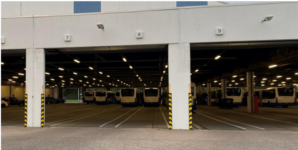
Figuur 24 - garage Noord, er zijn 20 banen voor het stallen van bussen
