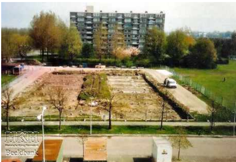
7 – 1992, zicht op bouwwerkzaamheden voor het appartementencomplex wat in dat jaar zal worden opgeleverd. Het complex is met de langsijde parallel aan de Maerelaan gesitueerd, tussen de flatgebouwen locatie 1 en 2 in. Afbeelding: HKH.
