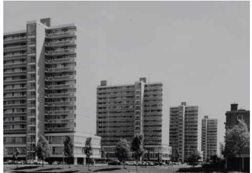
15 -ca.1965, flatgebouwen aan de Europaboulevard in Buitenveldert, Amsterdam, naar ontwerp van architectenbureau Gmelig Meyling, Zanstra en De Clerq Zubli. Afbeelding: Stadsarchief Amsterdam.
