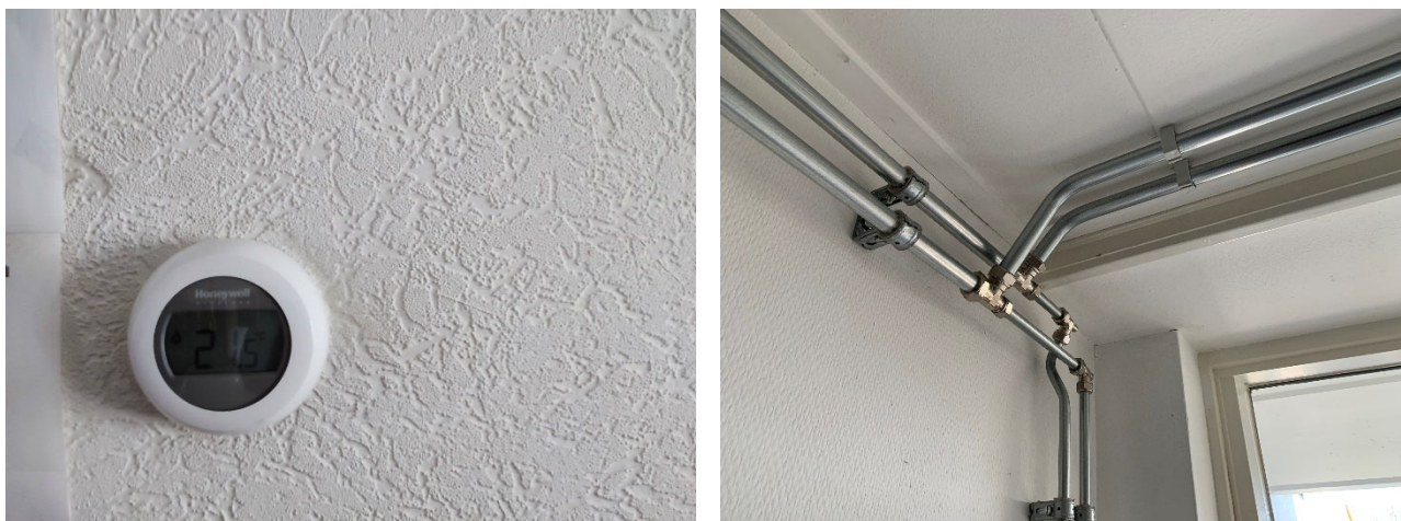
Afbeelding 2.3: Links thermostaat in de woonkamer – rechts het vernieuwde cv-leidingwerk.
