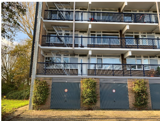
Afbeelding 5.1: Vluchtrap tot 1 e verdieping
