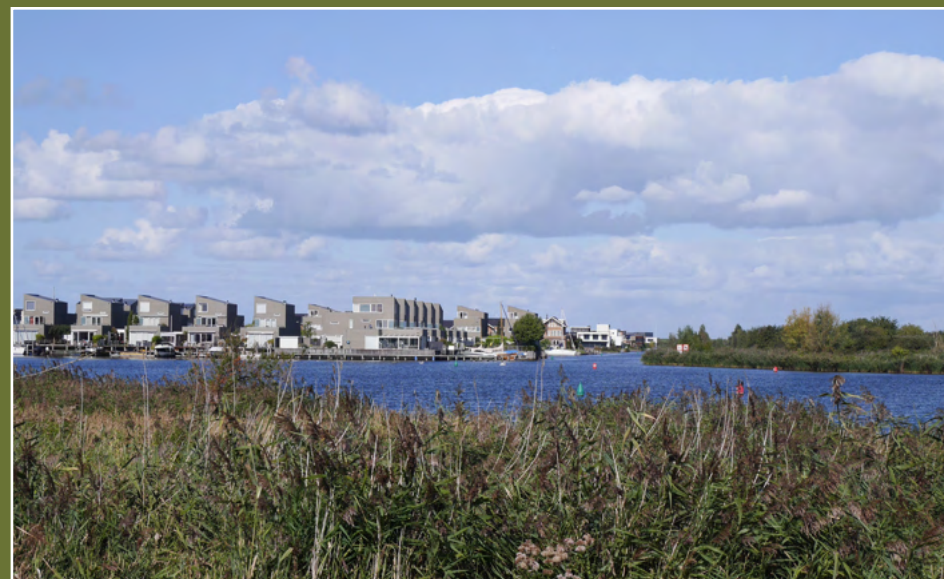
Zicht vanaf het eiland op de bestaande bebouwing in Noorderplassen-West. ▲
