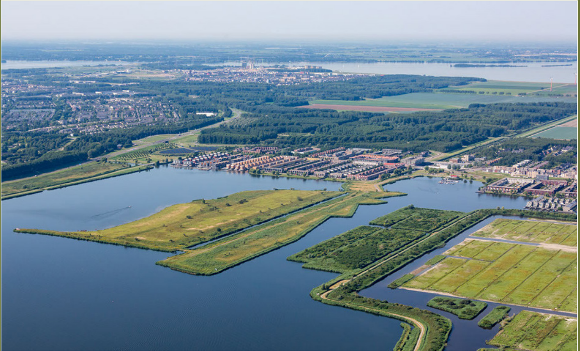
▲ Luchtfoto van Noorderplassen-West, kijkend naar het westen, met het eiland Isla Bonita op de voorgrond.
