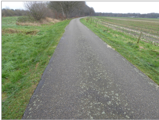
Foto 14: Sluisstraat, 500 m¹ uit Alphensebaan
