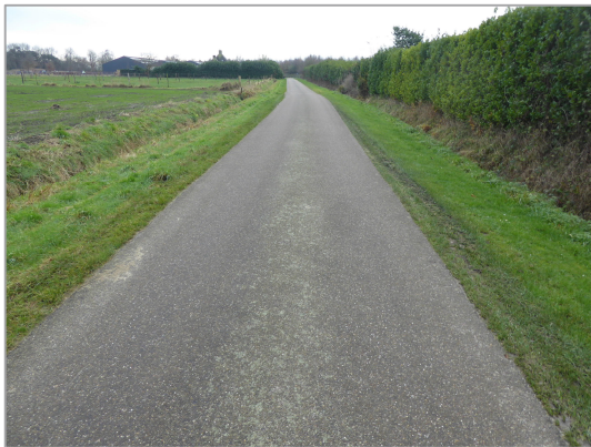
Foto 16: Sluisstraat, 1.000 m¹ uit Alphensebaan
