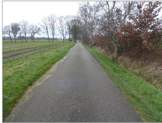
Foto 13: Sluisstraat, 500 m¹ uit Alphensebaan (foto richting Alphensebaan)
