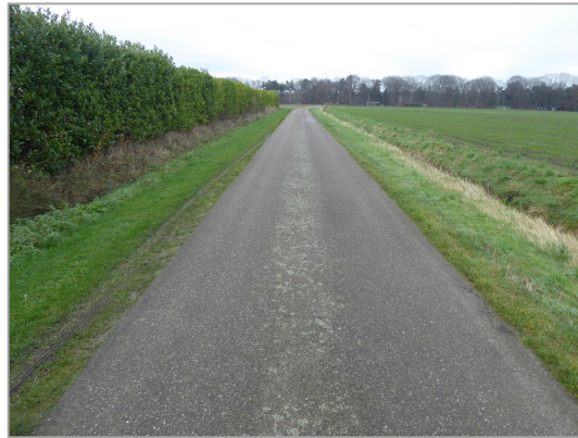
Foto 15: Sluisstraat, 1.000 m¹ uit Alphensebaan (foto richting Alphensebaan)
