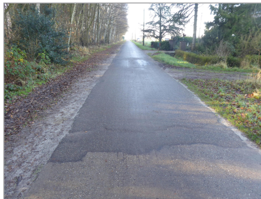
Foto 4: Haldijk, overgang asfalt/beton (foto richting Hooiberg)
