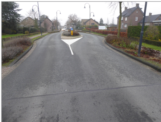
Foto 7: Dongenseweg, overgang EAB-recente SMA t.h.v. kombord
