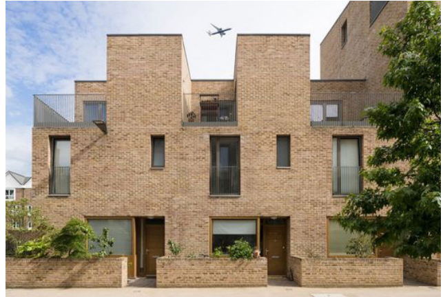
Voorgevels worden opgetrokken uit baksteen met houten accenten - Brentford Lock West, Engeland (bron: mikhailriches.com/).
