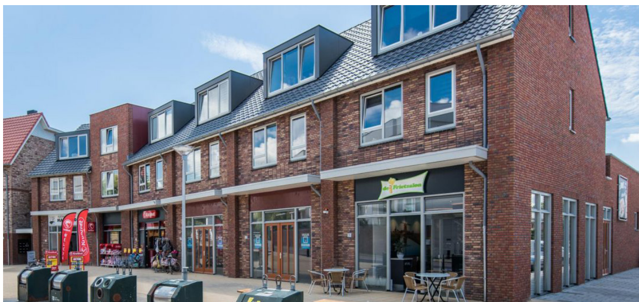
Kleischalige appartementenblok met voorzieningen in de plint
