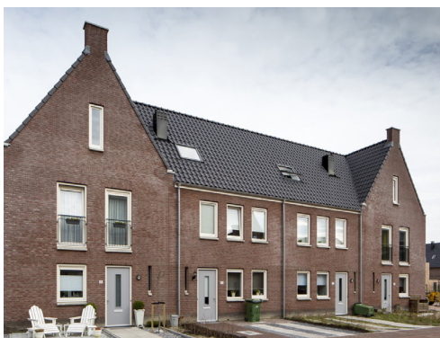
Vlakke gevels met zorgvuldige detaillering geven de gebouwen een moderne uitstraling
