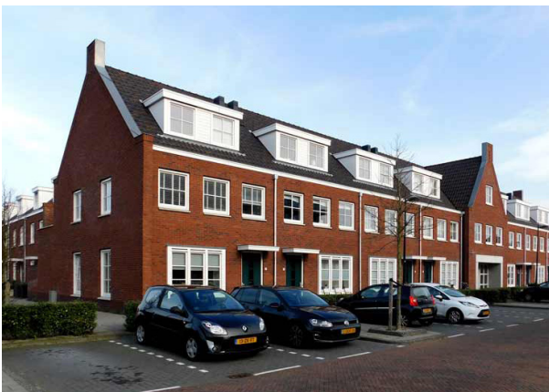
Benedenbovenwoningen met gevels in rood-bruin metselwerk
