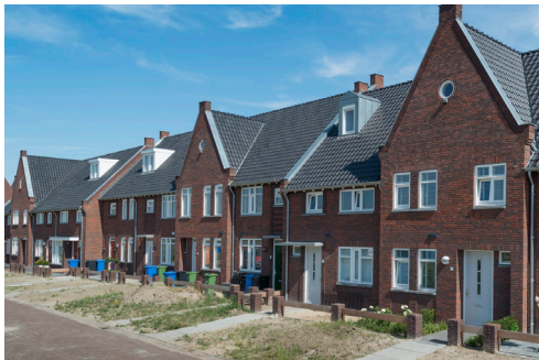
Gebouwen zijn opgetrokken in rood-bruin metselwerk en hebben kappen met grijze pannen. Een lichte kleur wordt als accentkleur toegepast.
