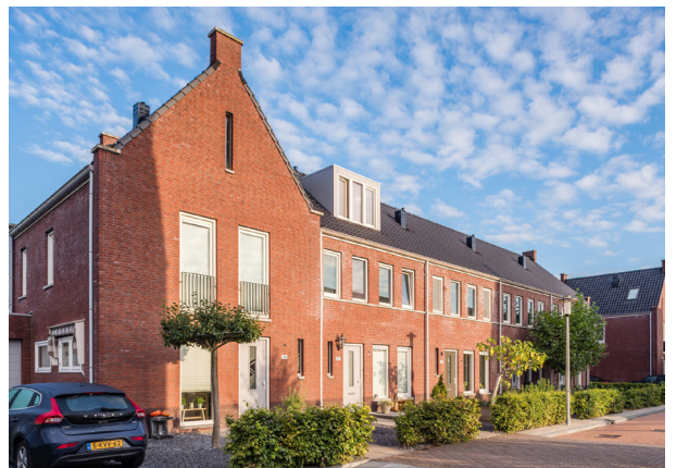
Zorgvuldig ontworpen vlakke gevels met moderne uitstraling
