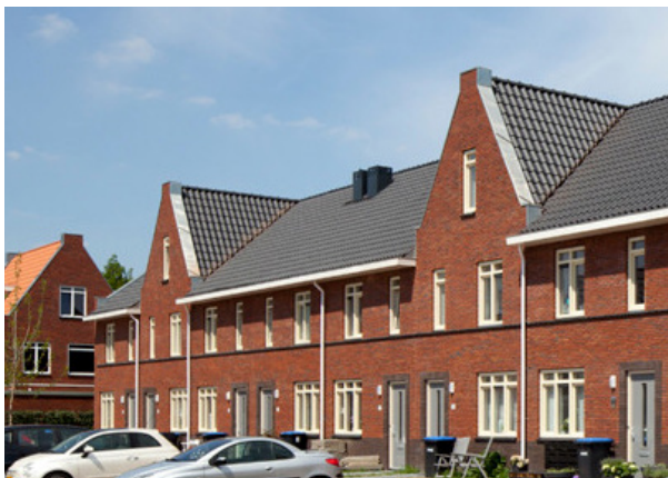
Tuitgevels in de langsgevel voor een gevarieerd beeld
