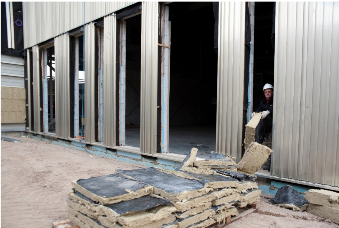
Op de foto is een bouwvakker aan het werk met isolatiemateriaal bij het Huis van de Sport, grenzend aan het toekomstige Park21.
