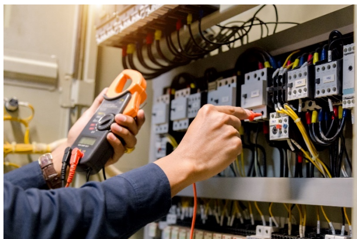
Werkzaamheden aan elektrische installatie
