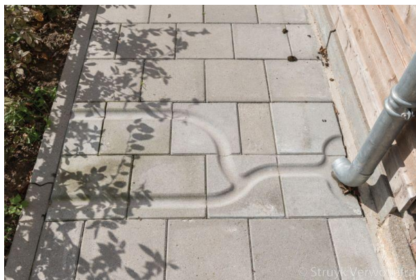
Ref. 2 Hemelwaterafvoertegels 30x30 i.c.m. met afkoppelstuk
