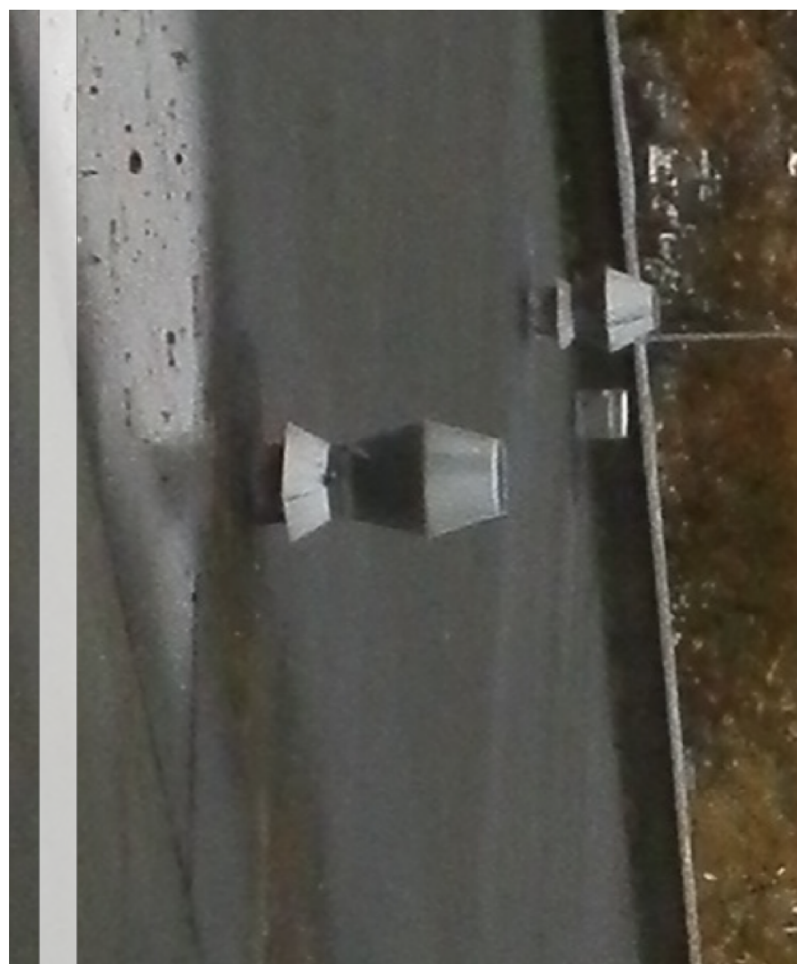
Detail 1: uitmondning uitlaattgasaafvoer
