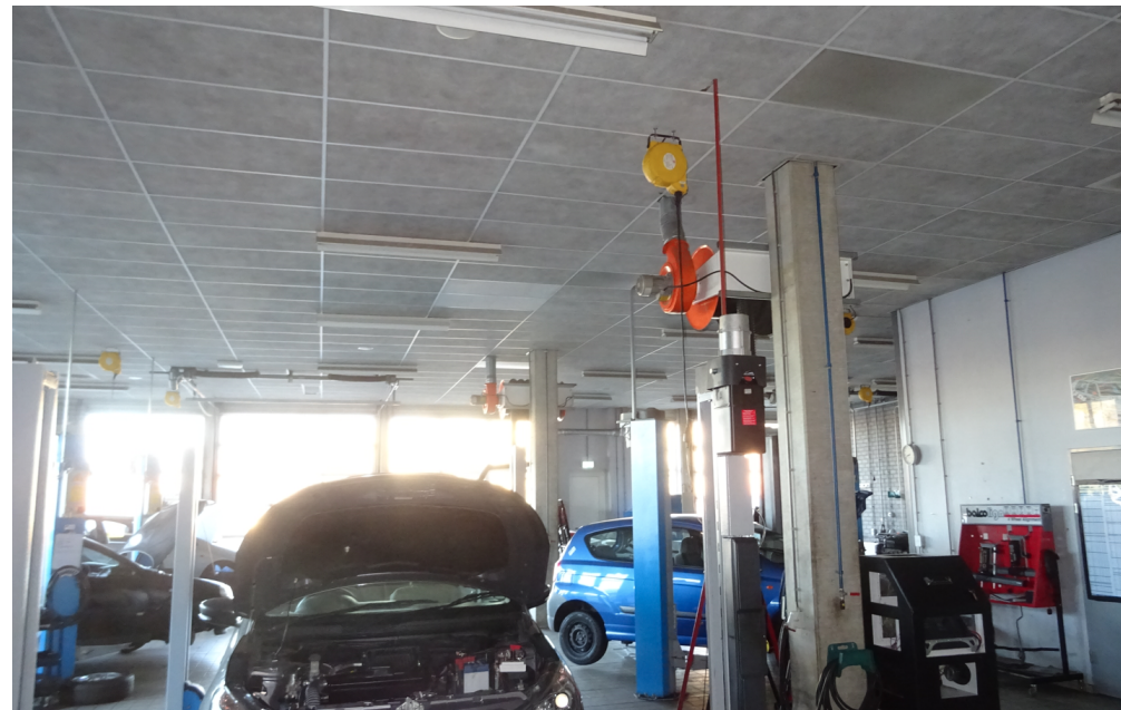
Detail 2: Uitlaatgassysteem (UGS) +230V katrolsysteem
