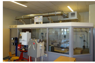
In bestaande vloer wordt een ventilatieunit geplaatst. Het kanaal wordt afgedekt met een afdekplaat.
