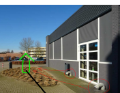
In bestaande vloer wordt een ventilatieunit geplaatst. Het kanaal wordt afgedekt met een afdekplaat.
