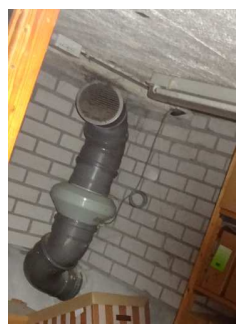
In bestaande vloer wordt een ventilatiekanaal met afdekplaat geplaatst.
