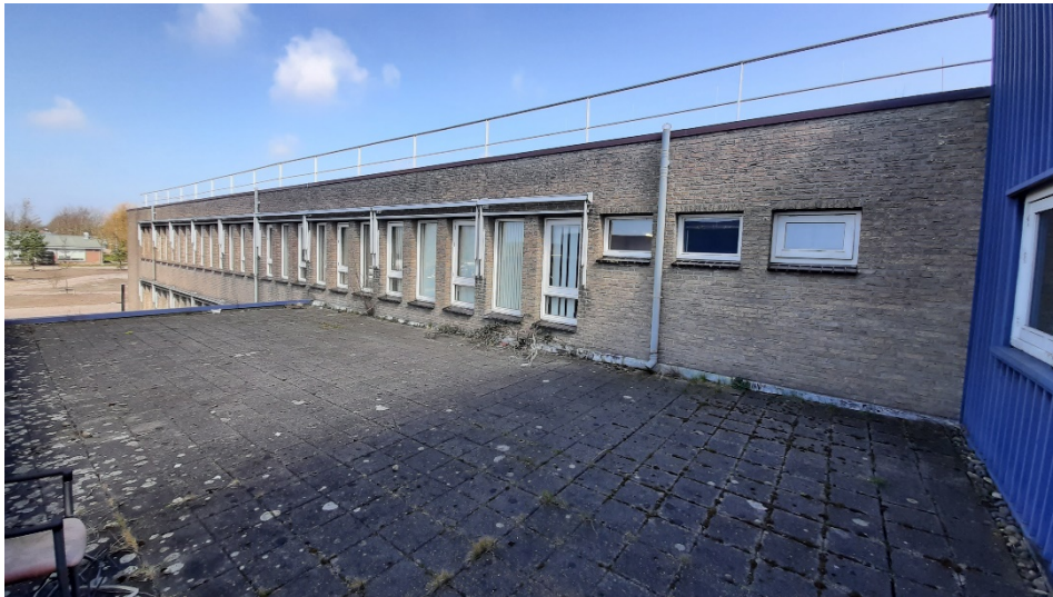
Figuur 5 - Overzicht gevel (schaduwzijde) met dakvlak B
