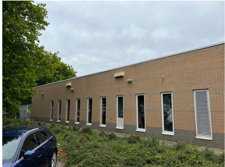
Foto 9: Noodoverstorten buitenzijde gevel
