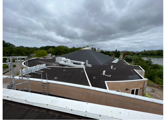
Foto 7: Overzicht daken zwembad
