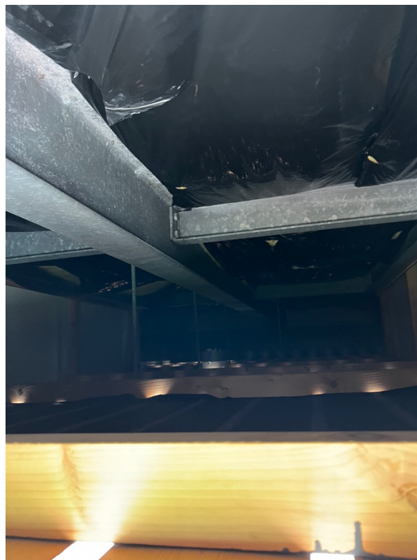
Foto 3: staalconstructie platte daken
