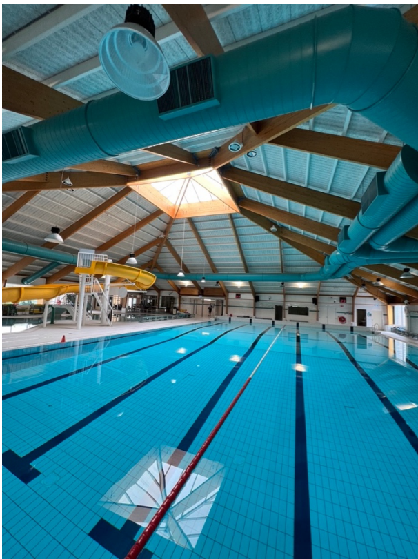
Foto 2: overzicht zwembad met houten spanten.
