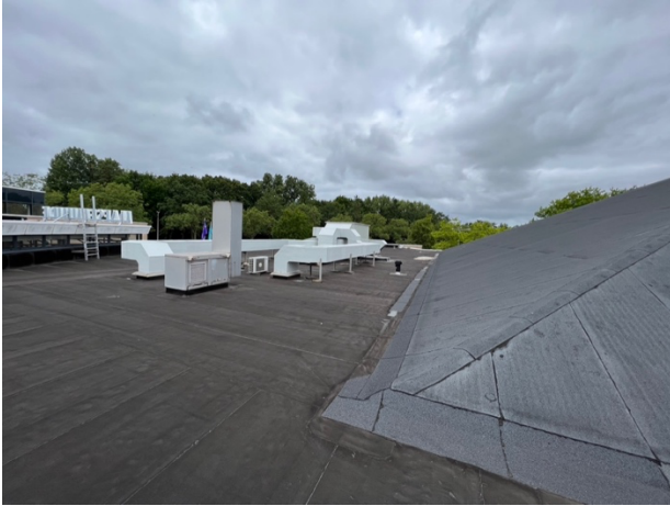
Foto 6: Overzicht platdak rondom zwembad.
