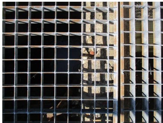
Schade: Betonschade 0,1m 2 met blootliggende wapening ter plaatse van oplegging roostervloer. Oorzaak: Lokaal onvoldoende betondekking. Risico: Verminderde duurzaamheid betonconstructie. Maatregel: Betonreparatie conform CUR-aanbeveling 118.
