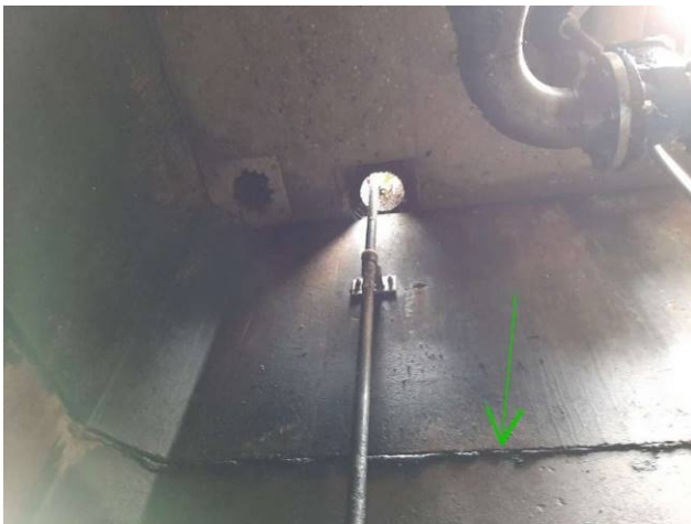
Kitafdichting tussen betondelen
