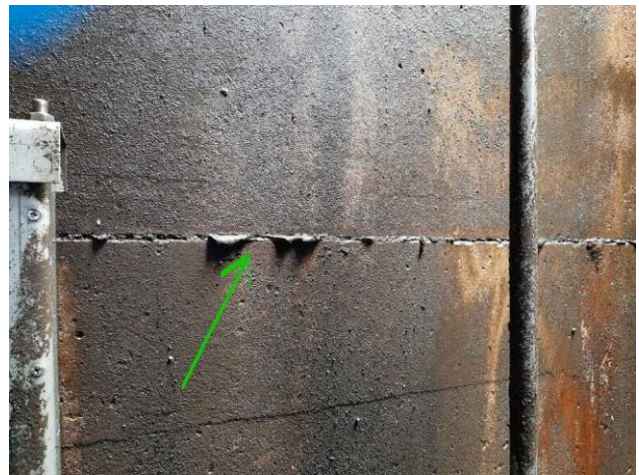
Kitafdichting tussen betondelen
