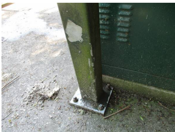
Schade: De conservering op het frame van de hijsinrichting bladdert op meerdere locaties. Oorzaak: Onvoldoende hechting van de verf op het verzinkte staal. Risico: Verminderde esthetica. Maatregel: Vervangen conservering stalen frame.
