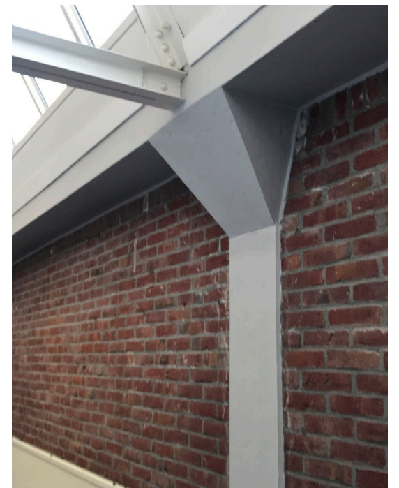
Beton skelet constructie
