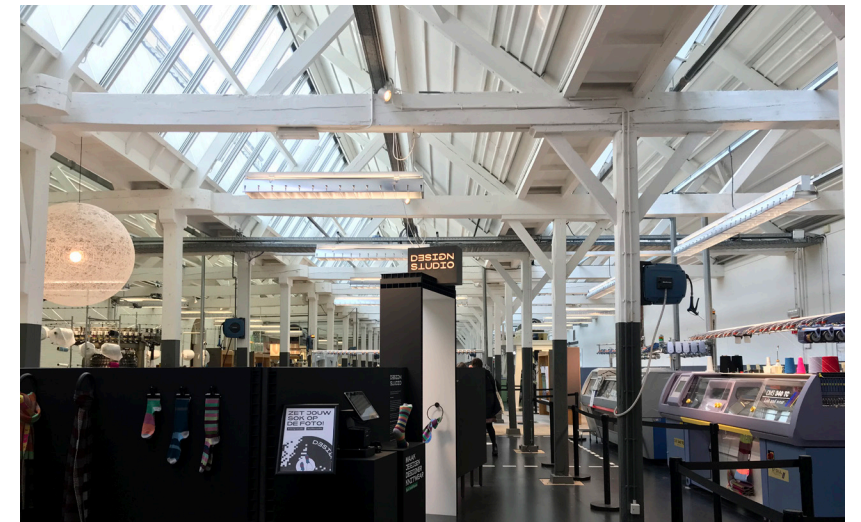
Sheddaken in het TextielLab met enkel glas: Installaties in het zicht
