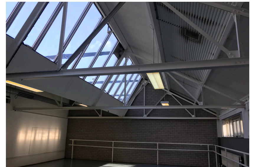
Sheddaken in het Drögepand met enkel glas
