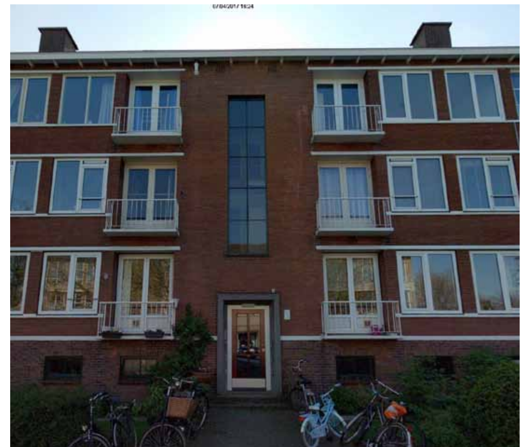
Bestaand: Woningen Oppenheimstraat
