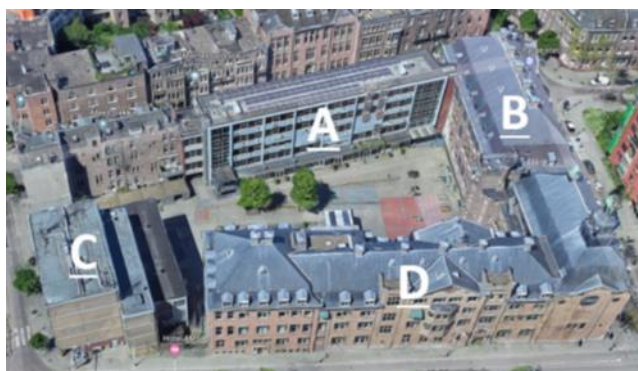
Situatie vóór de sloop van gebouw A en C. De sloop van de voormalige A en C gebouwen is separaat georganiseerd en momenteel grotendeels voltooid.
