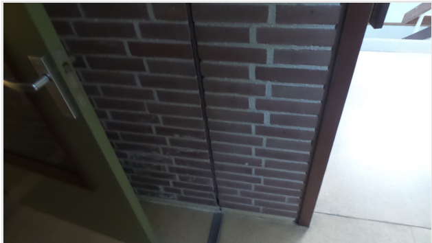
Dilatie in gang niet asbestverdacht.
