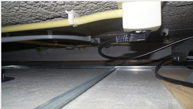
Ruimte boven systeemplafond.
