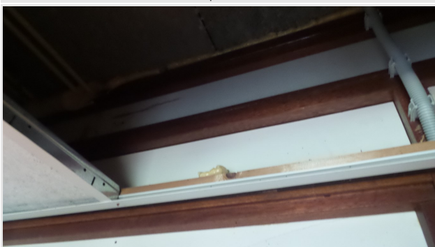
nobranda plaat boven deurkozijn
