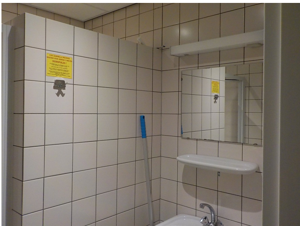
Doucheruimte: alle ruimten zijn iedentiek in dit gebouw
