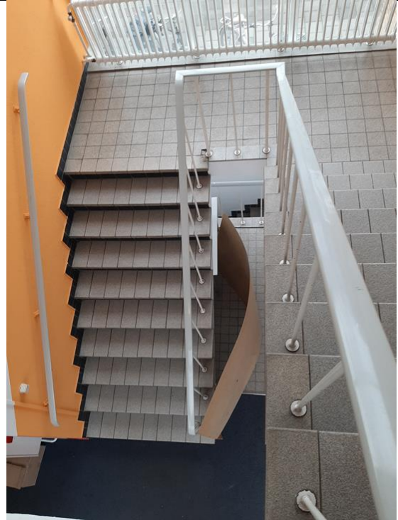
Trappenhuis in de uitbreiding aan de Van Maasdijkstraat
