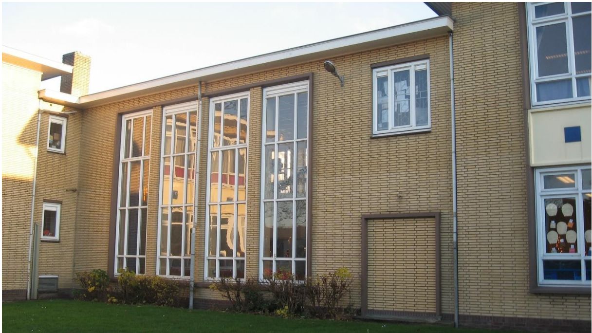
Hal met hoge ramen en binnen de betonnen lijst was in 1955 nog een entree (foto 2009)
