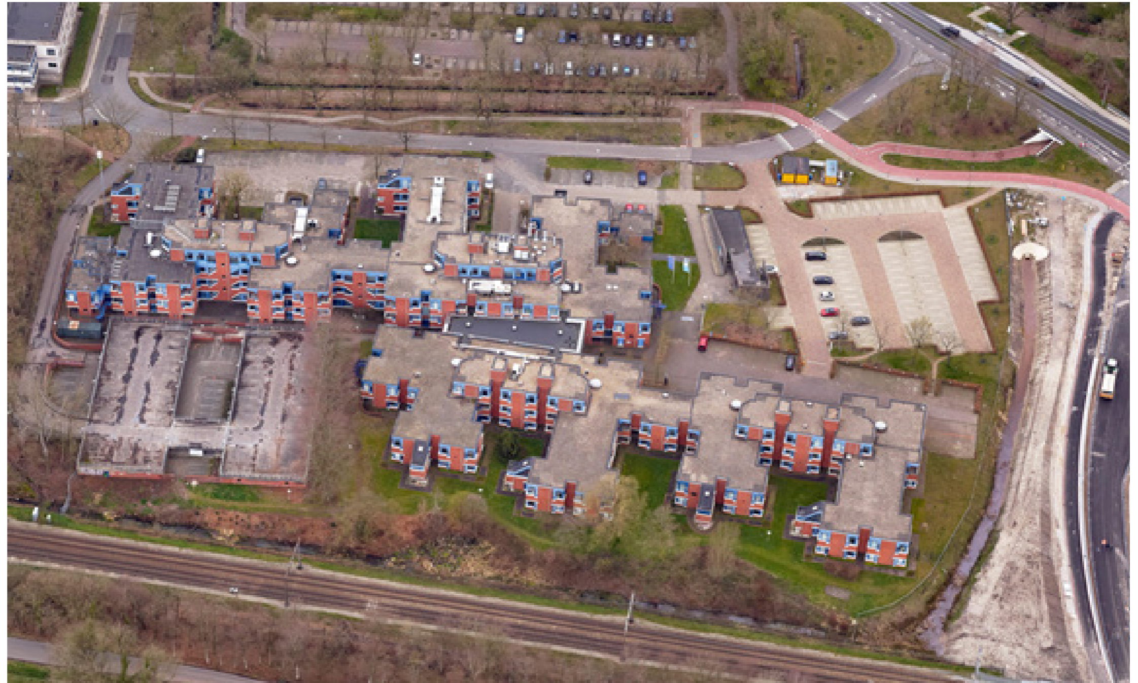
Luchtfoto Mandemaat 3, vanuit oostelijke richting (19 maart 2020)
