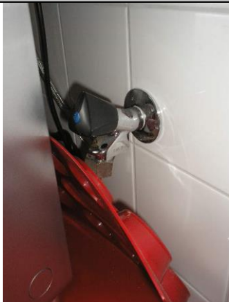
Foto 9: Vulkraan drankenautomaat
