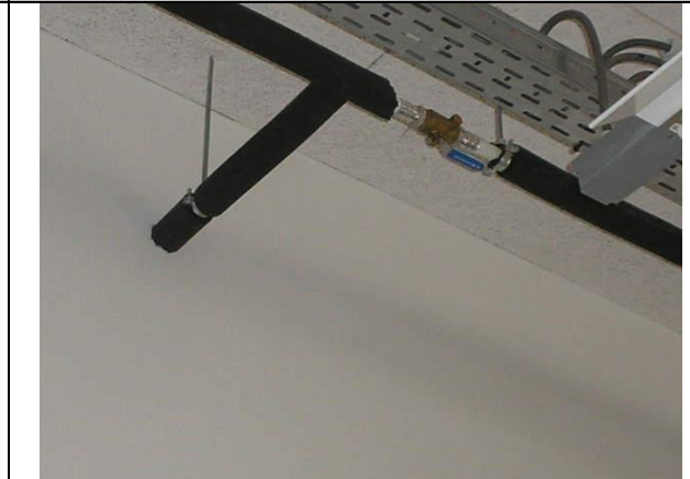
Foto 16: Aanvoerleiding buitenkraan
