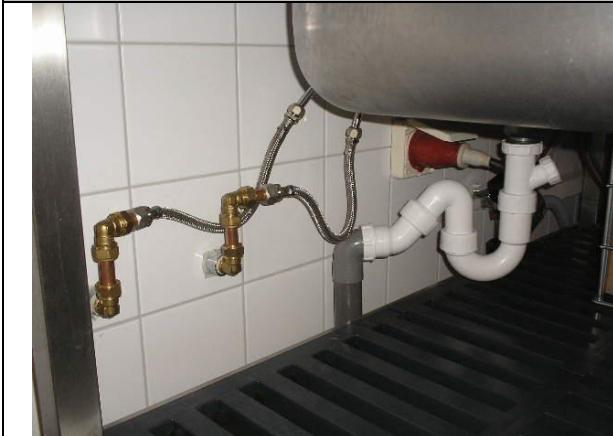
Foto 15: Aansluiting knijpdouche
