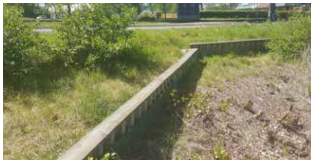
ref.: begeleiding naar faunapassage (1)
