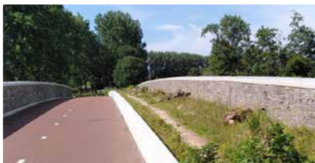
ref.: faunapassage op een viaduct (3)
