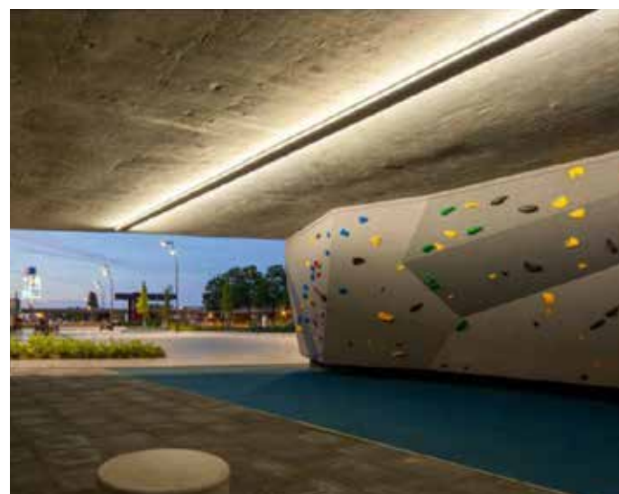
2. Tunnelverlichting - Stamina, Modernista
