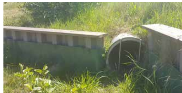
ref.: begeleiding naar faunapassage (1)
