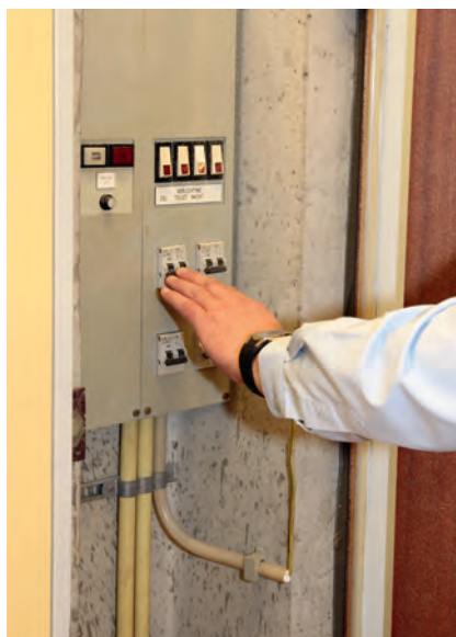
Afbeelding 3.5 uitschakelen van de elektriciteit
