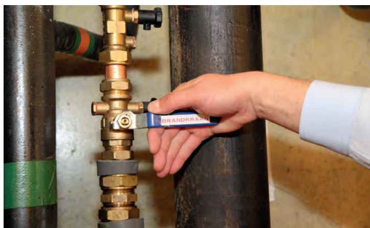
Afbeelding 3.10 voorbeeld handbediende sprinkler
