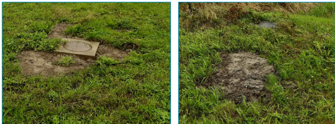
Foto's gedichte gaten in leeflaag
